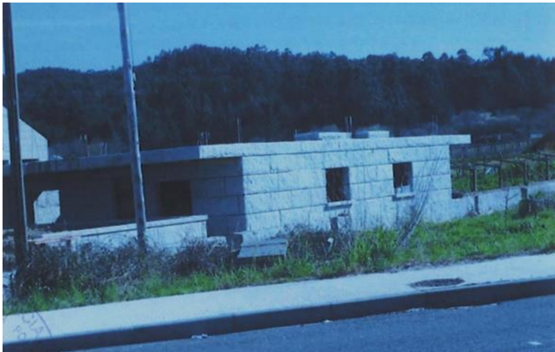
antes da demolición
