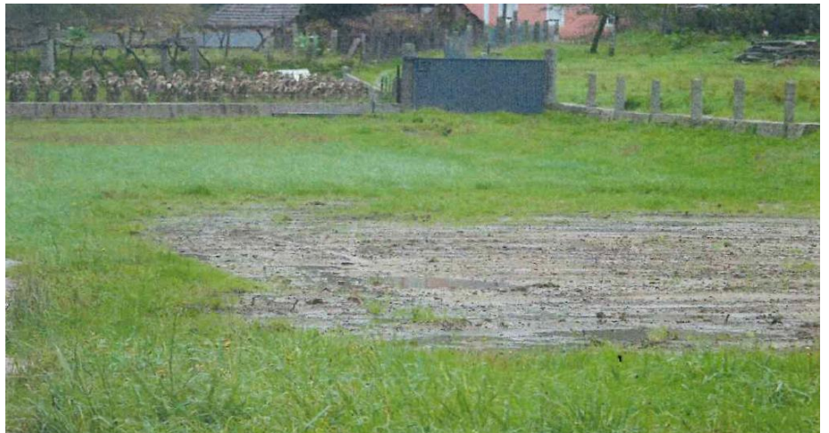
Despois da demolición
