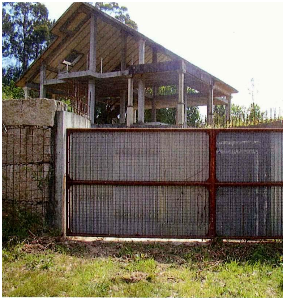
antes da demolición
