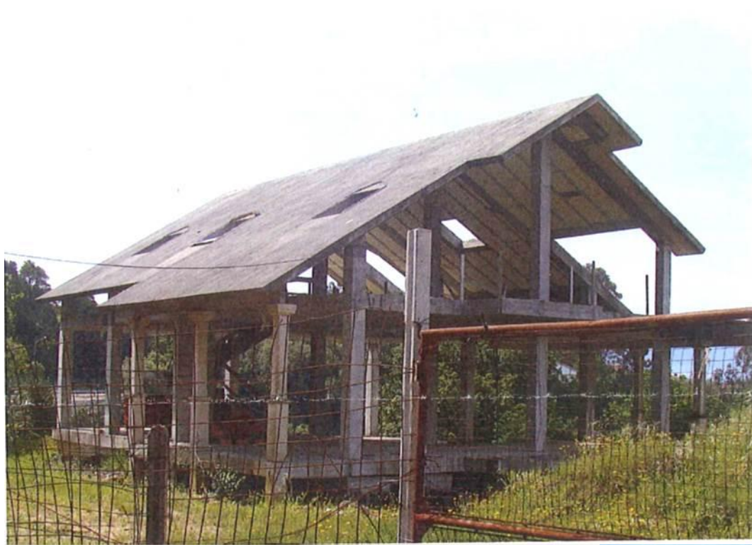
antes da demolición
