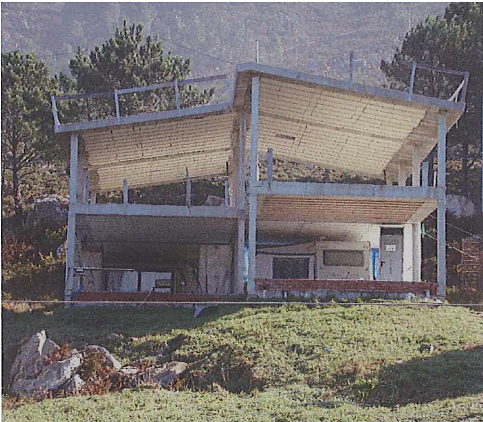
antes da demolición
