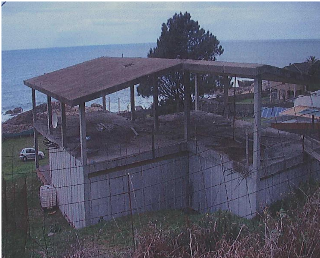
antes da demolición
