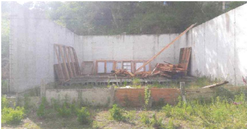
Antes da demolición
