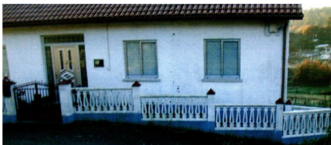
Despois da demolición
