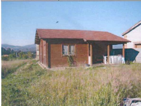
Imaxe da inspección de 22.06.2016
