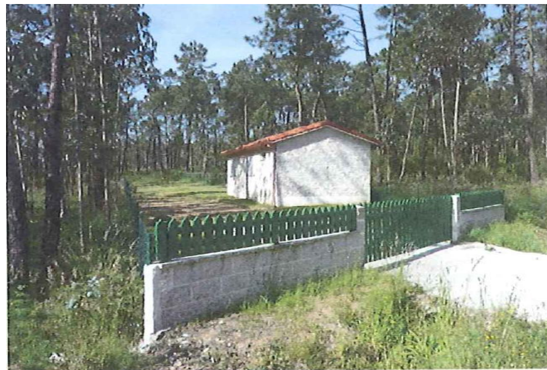
antes da demolición
