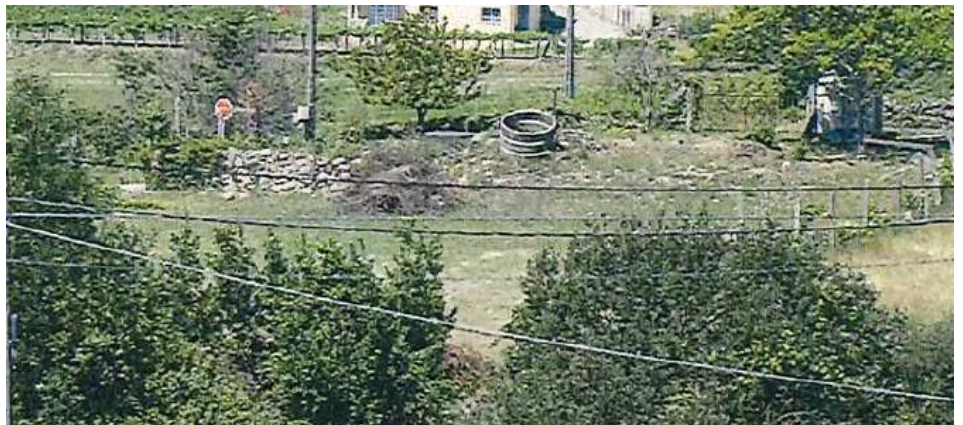
Despois da demolición
