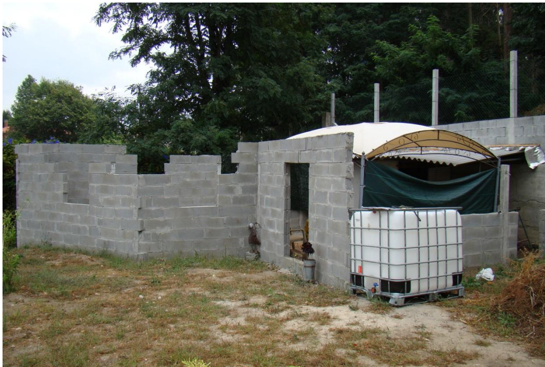
antes da demolición
