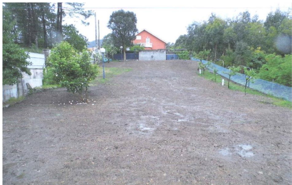
despois da demolição
