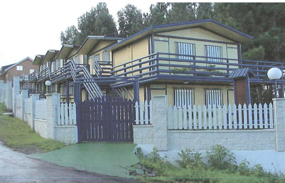
antes da demolição
