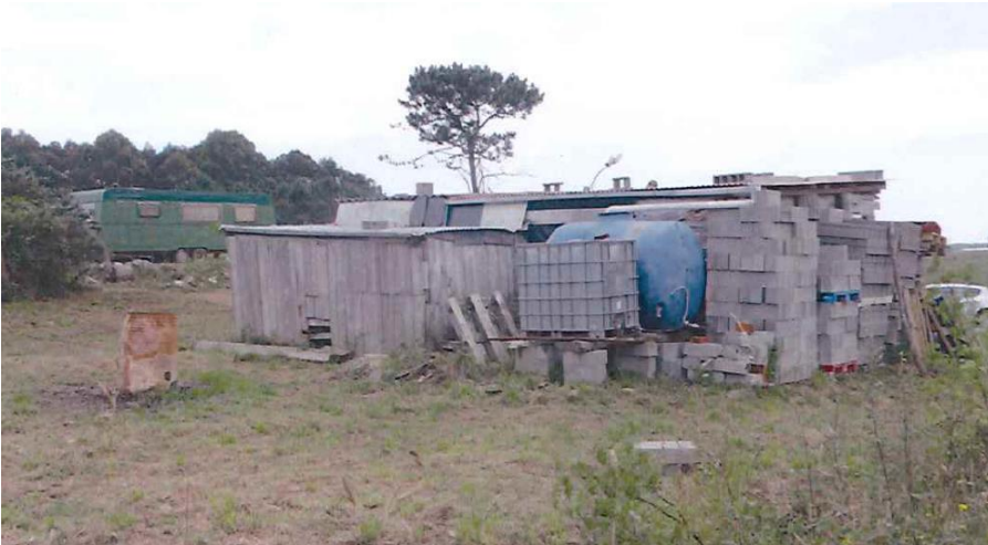
Antes da demolición
