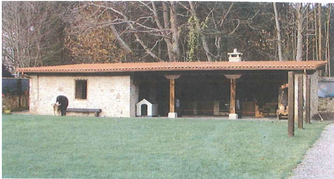
antes da demolição
