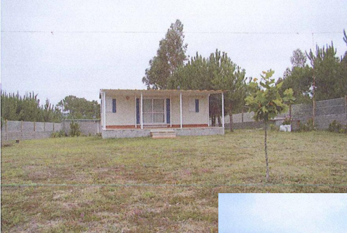
antes da demolição
