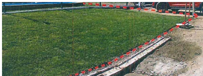
Despois da demolición
