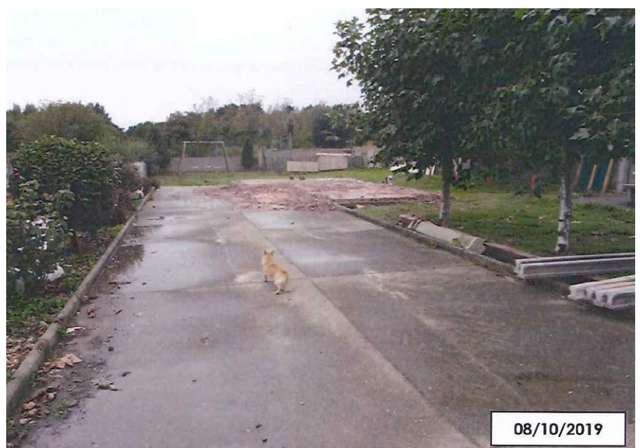
Despois da demolición
